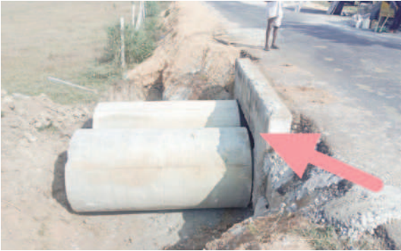
సిఎం గ్రామానికి వెళ్లే మార్గంలో నాసిరకం కల్వర్టు నిర్మాణ పనులు
